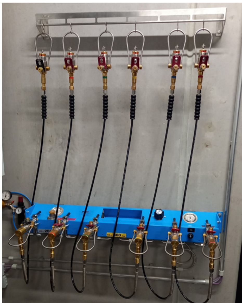
Remplissage des bouteille d'air respirable avec fiche WEH® connecteur TW154.
